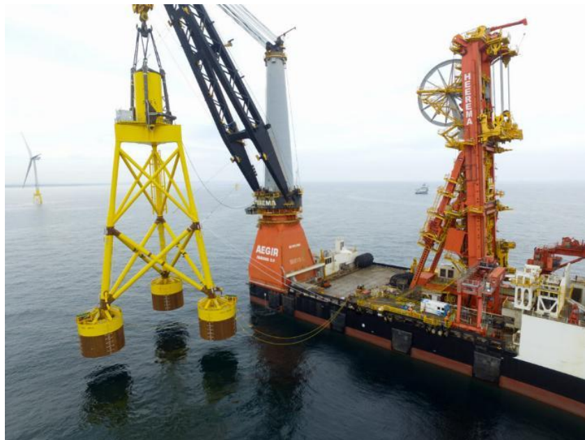
Figure 1-12: Installation d'un jacket à 3 jambes et aux ancrs à succion en mer [SPT Offshore, 2024]
