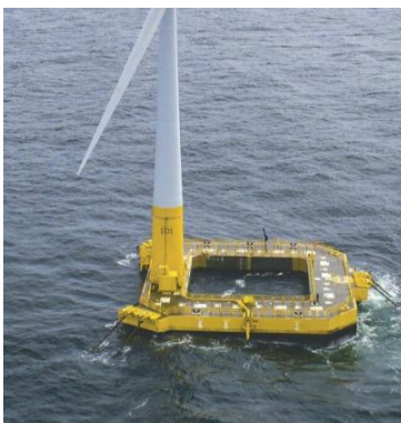
Barge : BW Ideol au Croisic (2MW)
