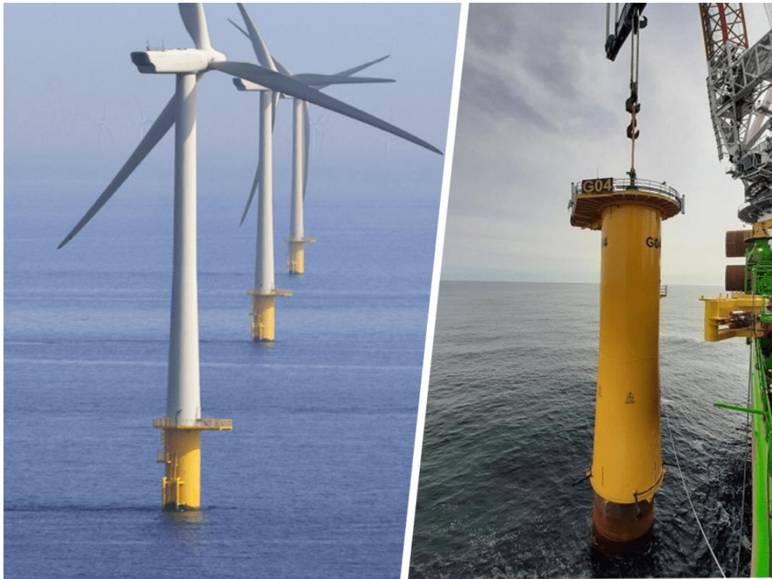
Figure 1-10 : Parc éolien avec fondations monopieux (gauche) et installation d'un monopieu en mer (droite) [Enerpac, 2022]
