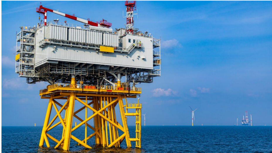
Figure 1-2: Poste électrique en mer posée [The Energy Law Blog, 2023]
