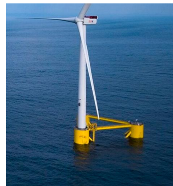
Semi-submersible : Principe Power au Portugal (8MW)
