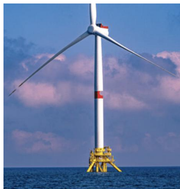
TLP : SBM en Provence (8MW) - à noter que la plus grande partie de la structure flottante est submergée
